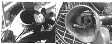
รูปที่ 2-17 ตัวอย่าง Pilot Burners
